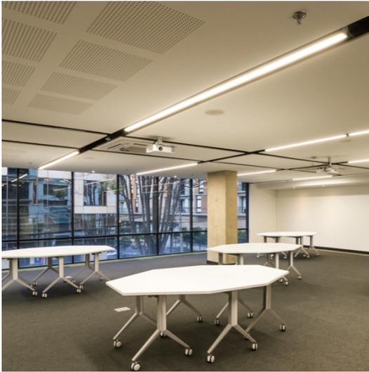
**ESPECIFICACIONES ELÉCTRICAS:****Voltaje/Tensión de Entrada:** 120-240 VAC**Amperaje:** 0.133A @120 VACA**Potencia:** 16W**Factor de Potencia:** >0.9**Atenuable:** Si**OTRAS ESPECIFICACIONES TÉCNICAS:****Temperatura Ambiente:** -10° ~ 40°**Vida Útil:** 30.000 Horas**Garantía:** 3 años**Instrucciones de Instalación y Otras
